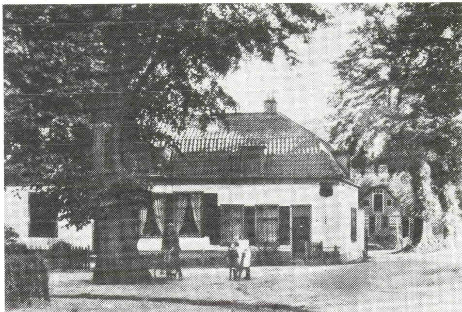
De „Drie Ringen” met op de achtergrond „Bakkerij van Brummelen” voor de restauratie 1974.
